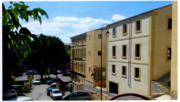
La Maison médicale de la Poste
